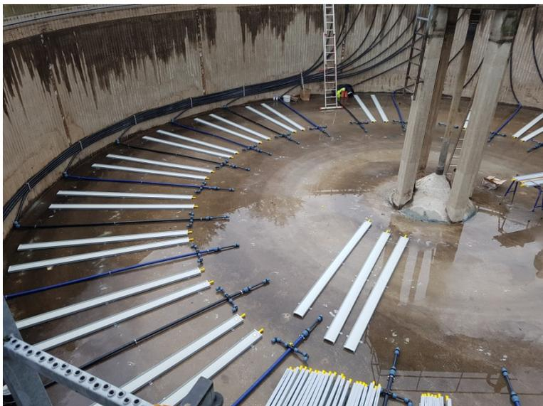
Die Belüftungsanlage der Kläranlage musste für ca. 120.000 € erneuert werden, da die Reinigungsleistung derart nachgelassen hatte, dass die behördlich genehmigten Werte kaum noch eingehalten werden konnten.
